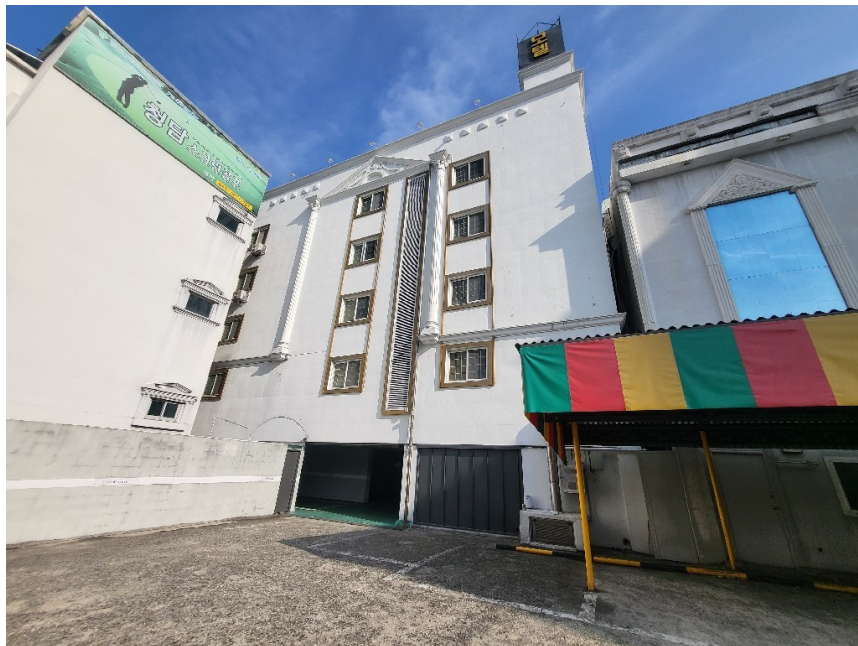
본건 후면 전경(남서측에서 촬영)
