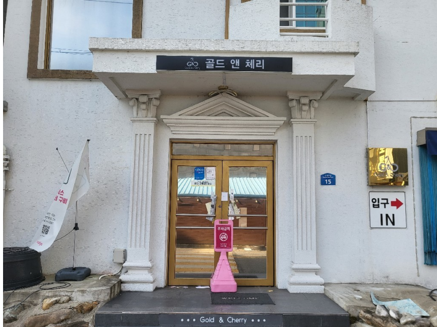
본건 출입구 전경
