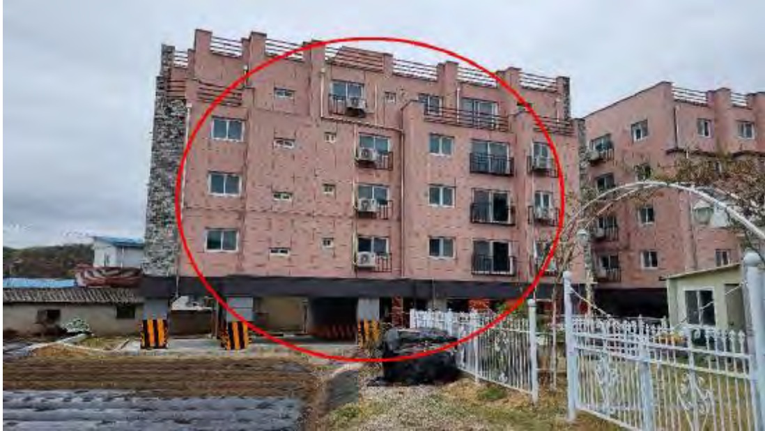
제씨동 건물 전경
