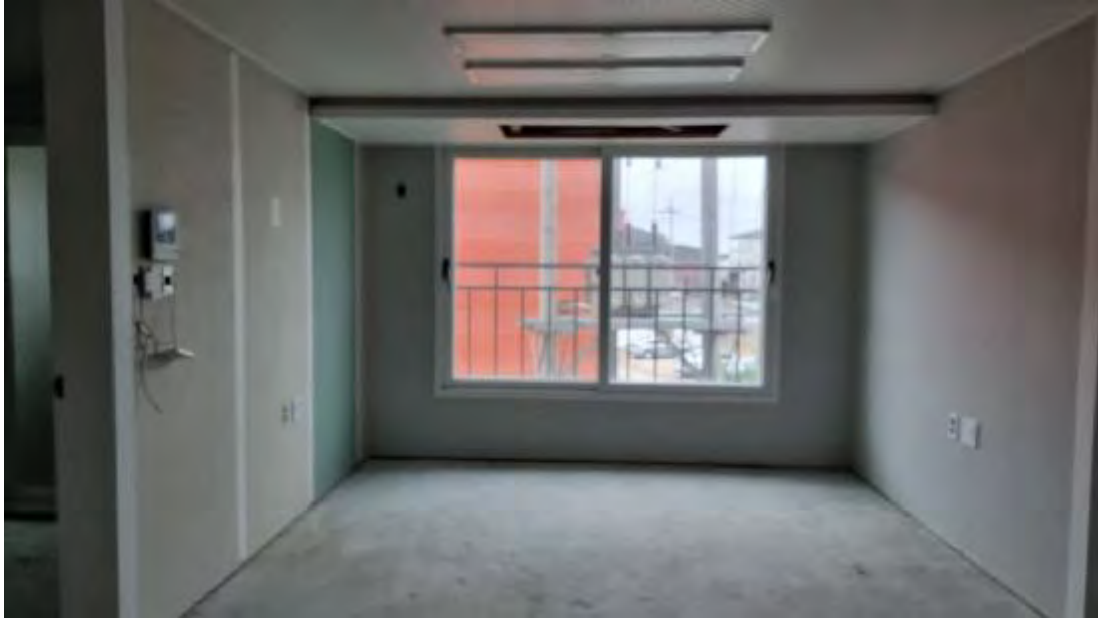
제에이동 제3호 라인 내부 전경
