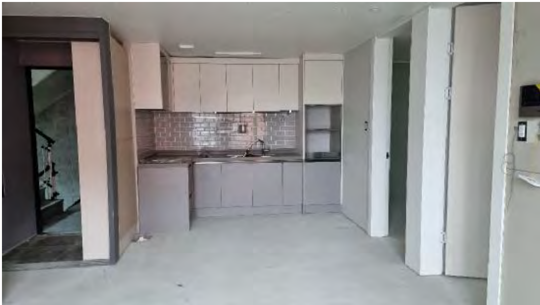
제에이동 제3호 라인 내부 전경
