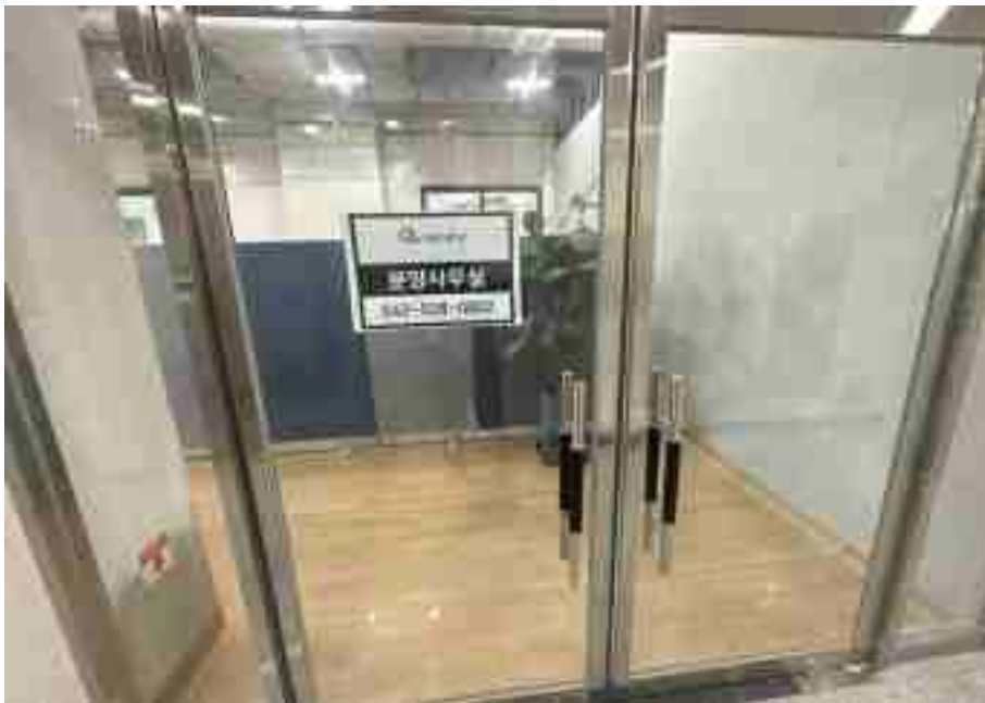
기호(46) 출입문 전경
