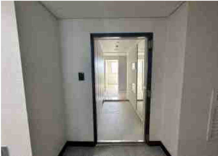
기호(6) 출입문 전경
