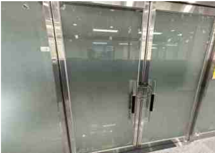
기호(48) 출입문 전경
