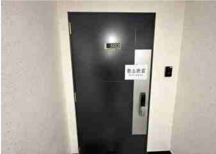
기호(3) 출입문 전경
