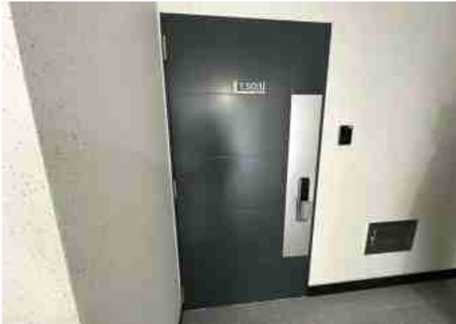
기호(바) 출입문 전경
