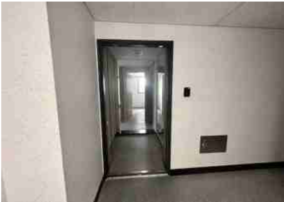
기호(16) 출입문 전경
