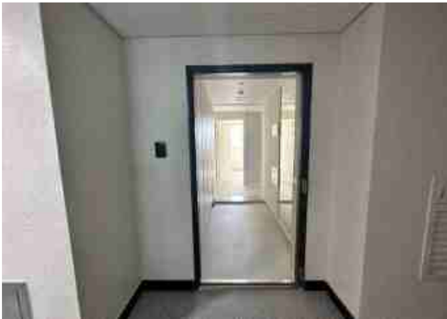
기호(8) 출입문 전경
