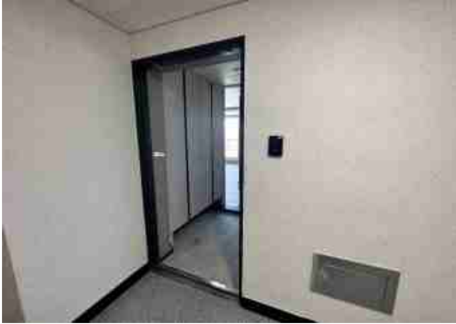
기호(29) 출입문 전경
