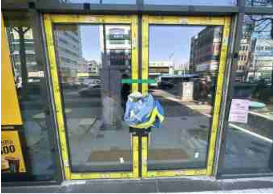
기호(43) 출입문 전경
