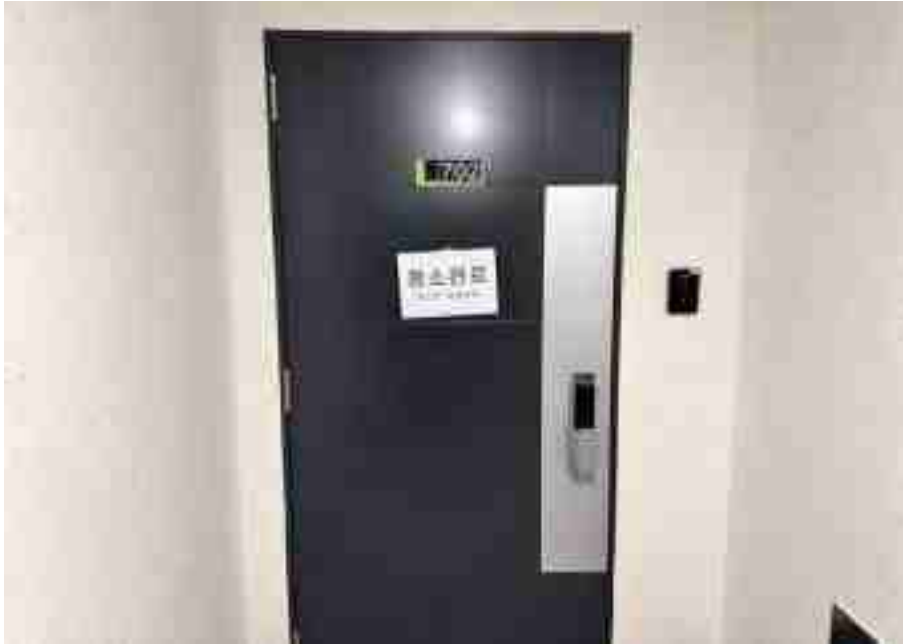
기호(3) 출입문 전경
