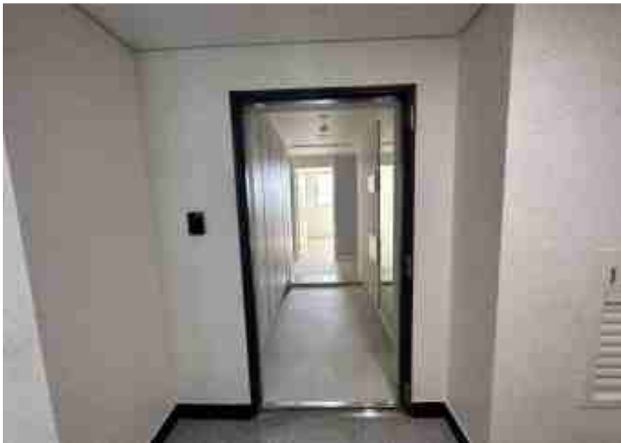
기호(10) 출입문 전경
