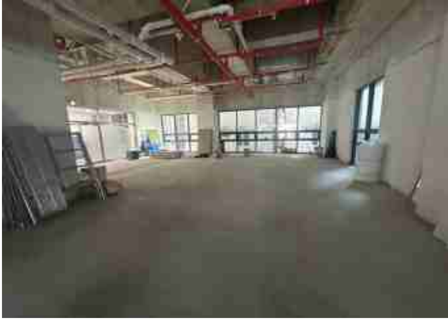
기호(48) 출입문 전경
