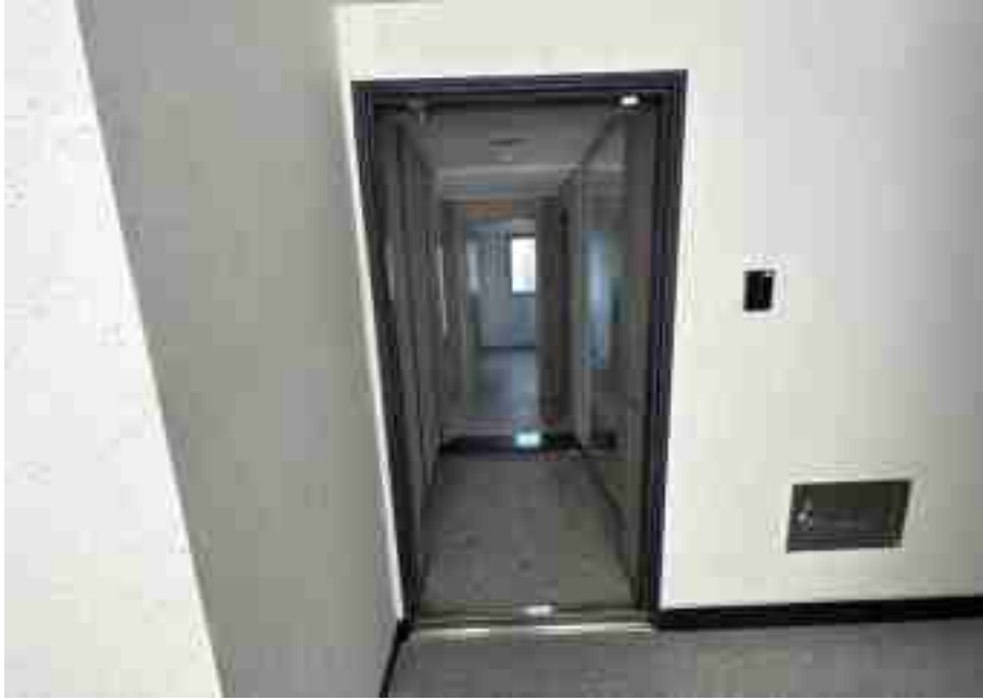
기호(13) 출입문 전경
