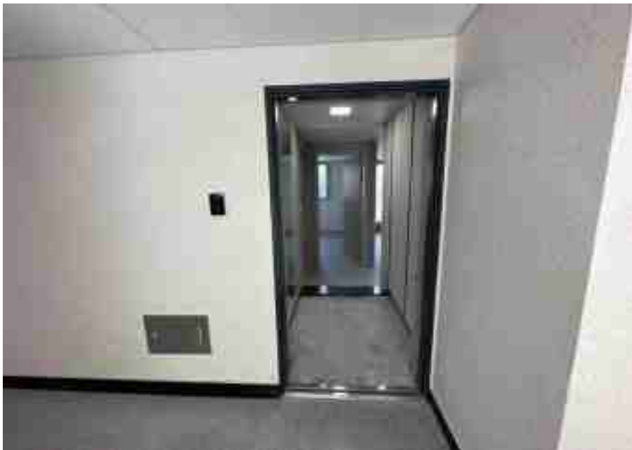
기호(12) 출입문 전경
