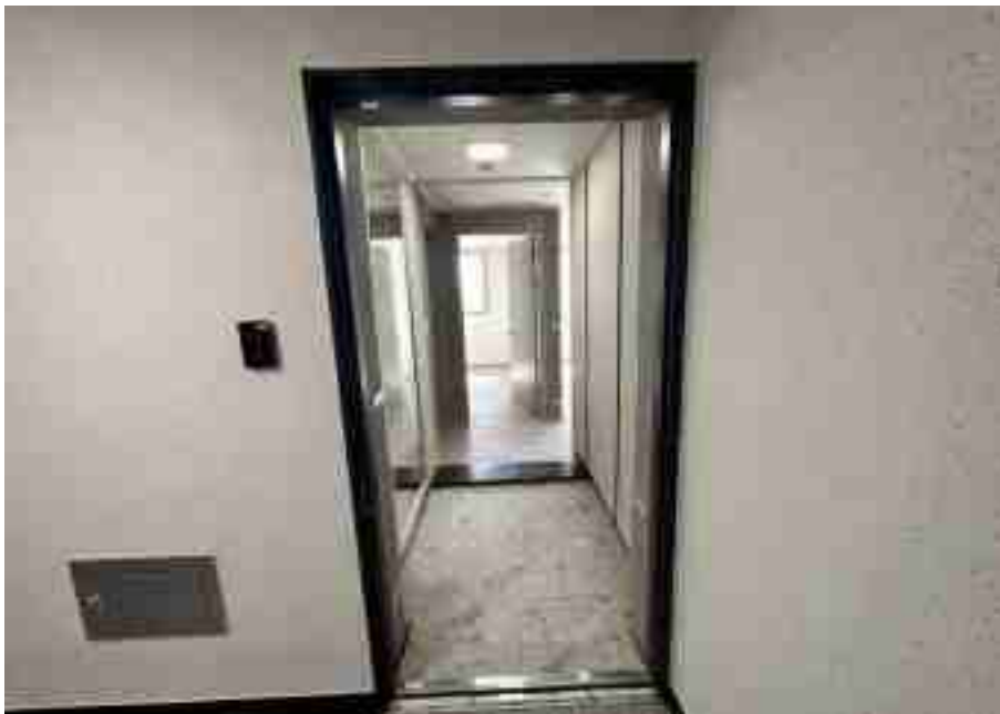
기호(38) 출입문 전경
