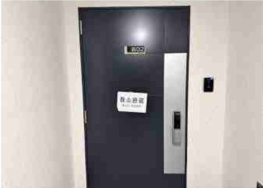
기호(5) 출입문 전경
