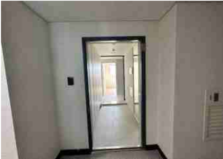
기호(4) 출입문 전경
