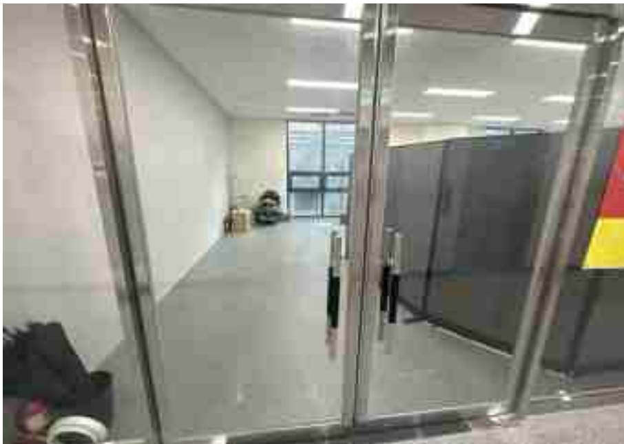
기호(47) 출입문 전경
