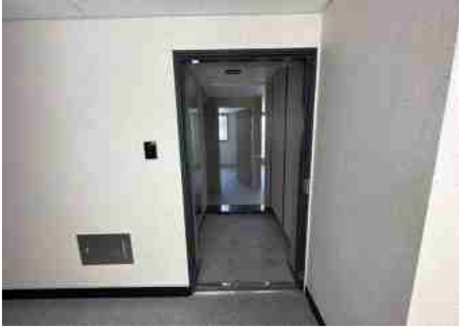
기호(9) 출입문 전경
