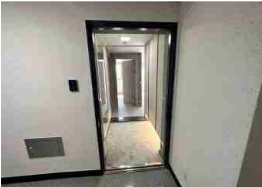
기호(40) 출입문 전경
