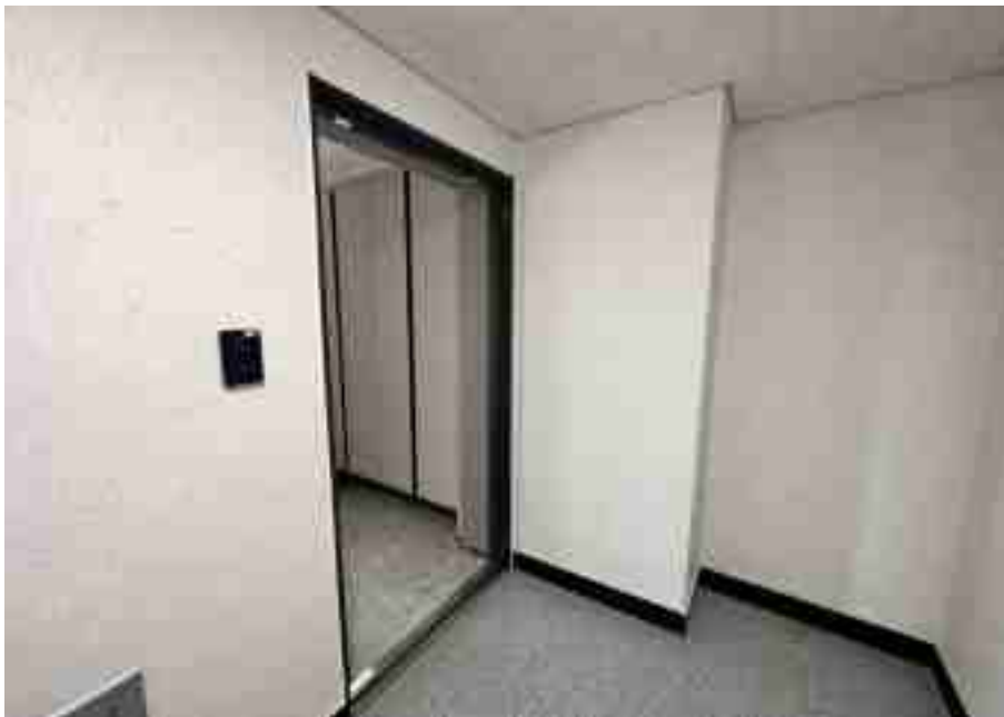
기호(26) 출입문 전경
