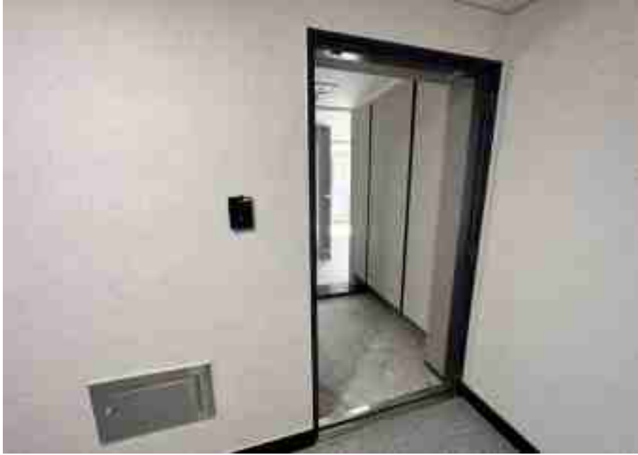
기호(23) 출입문 전경
