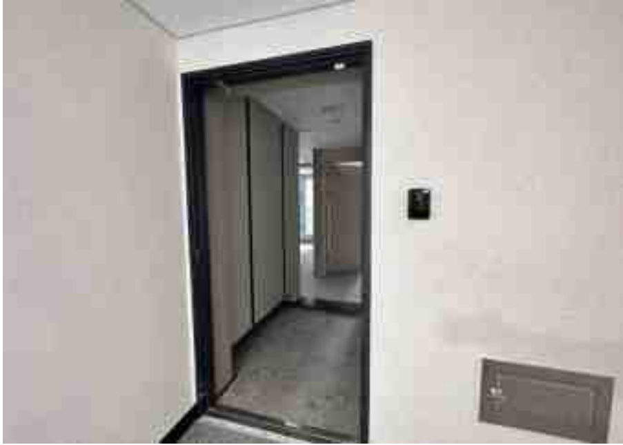
기호(25) 출입문 전경
