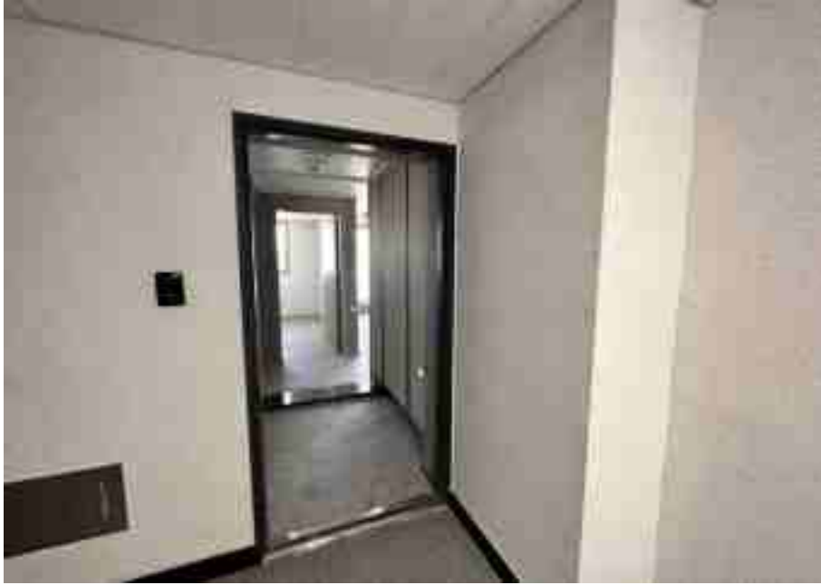
기호(33) 출입문 전경
