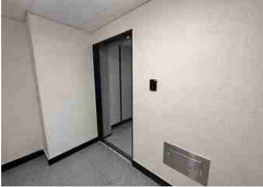
기호(15) 출입문 전경
