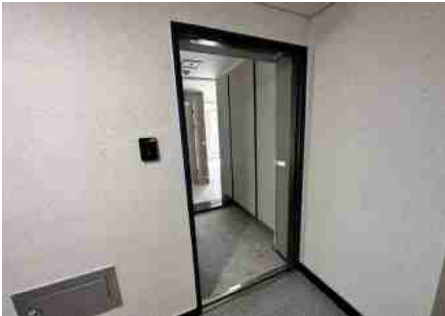
기호(34) 출입문 전경
