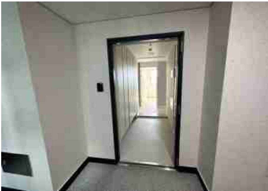
기호(12) 출입문 전경
