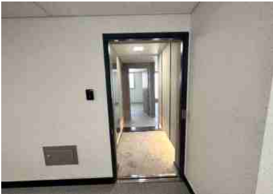
기호(36) 출입문 전경
