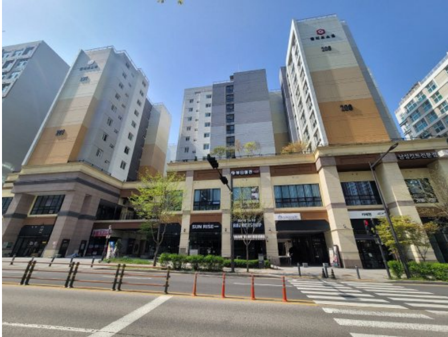
본건 전경(북동측 중로변)
