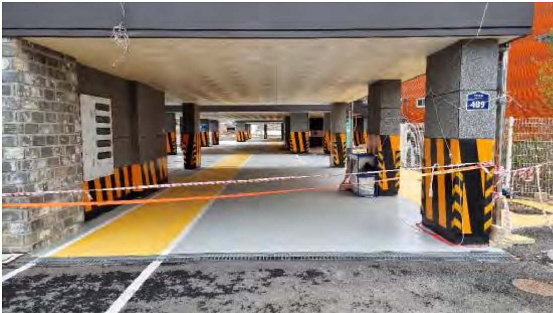
1층 주차장 전경
