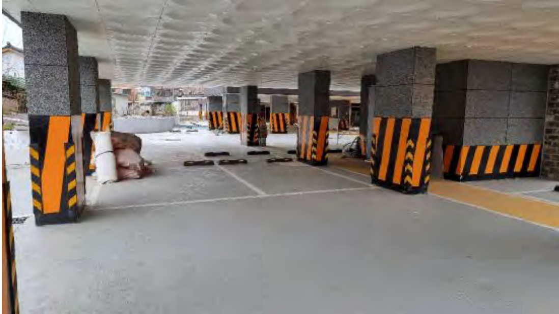
1층 주차장 전경
